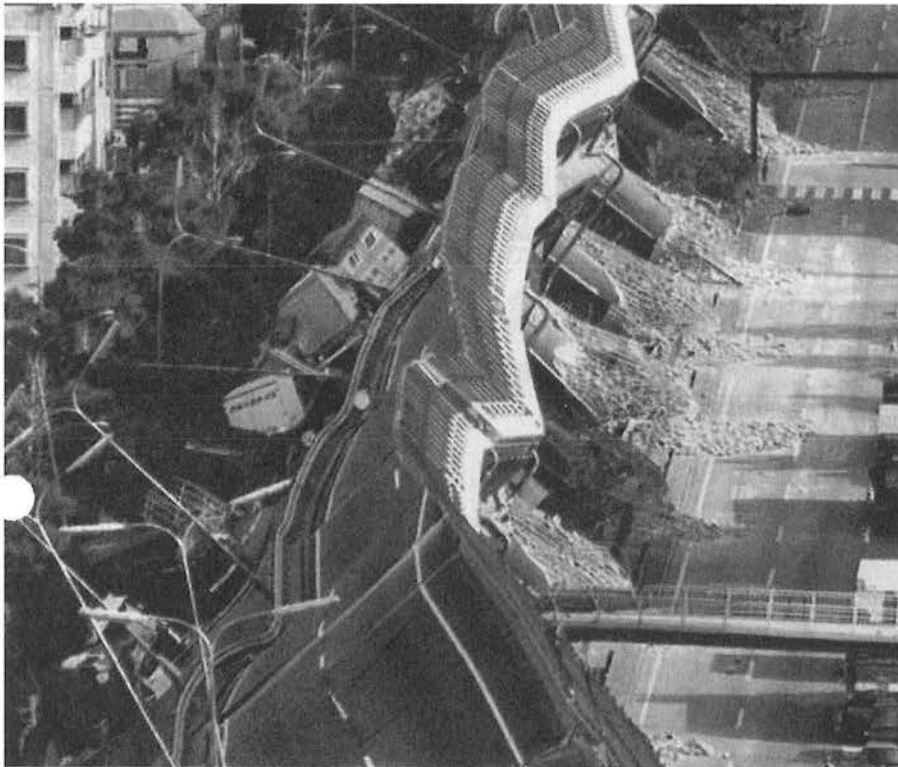
大地震は鉄道、道路網を破壊・寸断させる。(阪神大地震で倒壊した高速道路)
