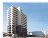
分譲マンション事業 WITHEARTH RESIDENCE ウィザースレジデンス
