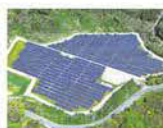
太陽光発電事業 MEGA SOLAR
